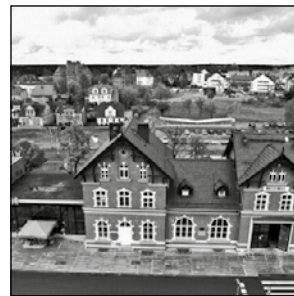
Odrestaurowany budynek dworca PKP w Wągrowcu
